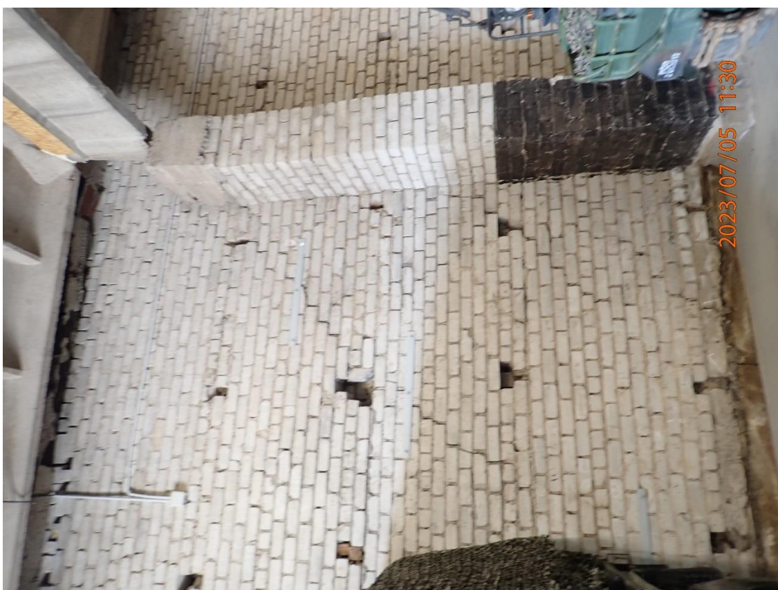
Nuotrauka Nr. 4. Išorinės skersinės (vakarinės) sienos deformacijos
