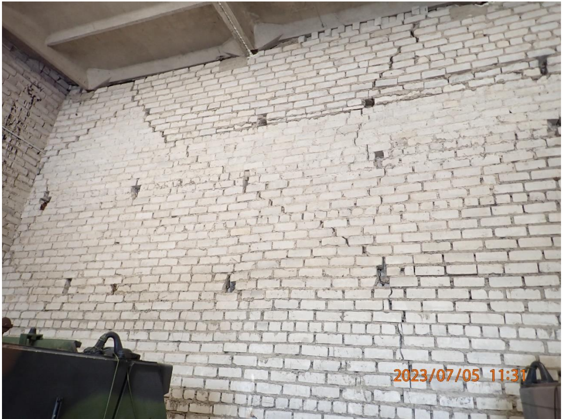
Nuotrauka Nr. 5. Vidinės išilginės sienos deformacijos, denginio plokštė atremta tiesiogiai ant mūro, o ne ant gelžbetoninės pagalvės
