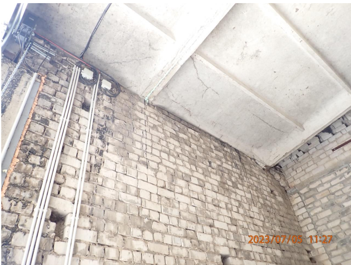
Nuotrauka Nr. 2. Vienas denginio plokštės išilginės briaunos galas neatremtas, kitas – atremtas tiesiogiai ant mūro, denginio plokštė neleistinai atremta ant galinės skersinės briaunos
